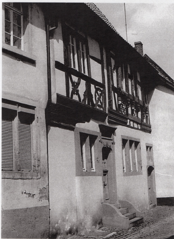
Schucksches Haus: Ansicht von Südwesten (April 1989)
