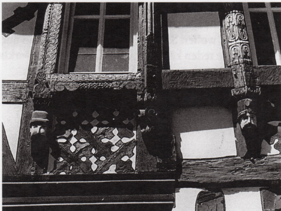
Figürliche Konsolen des Schnitzwerks unter den Fachwerkfenstern
